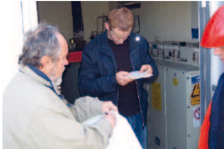
Kontrolle der ordnungsgemäßen Wartung der technischen Anlagen.
