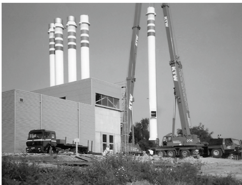
Bauphase vor 25 Jahren: Das Heizkraftwerk Gotha-West ist 1994 in Betrieb gegangen und ausgerüstet mit vier Gasmotoren sowie zwei Gaskesseln.
